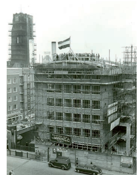
Bouw nieuw kantoor Rotterdam, 1952
