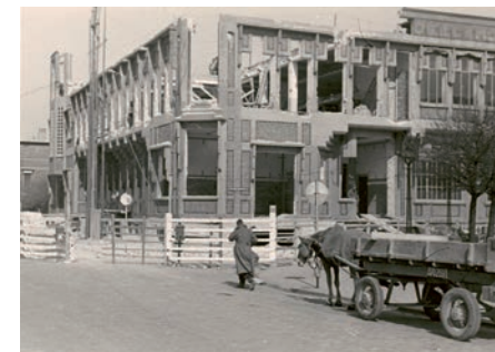
Beschadigd kantoor Den Haag, 1942.
